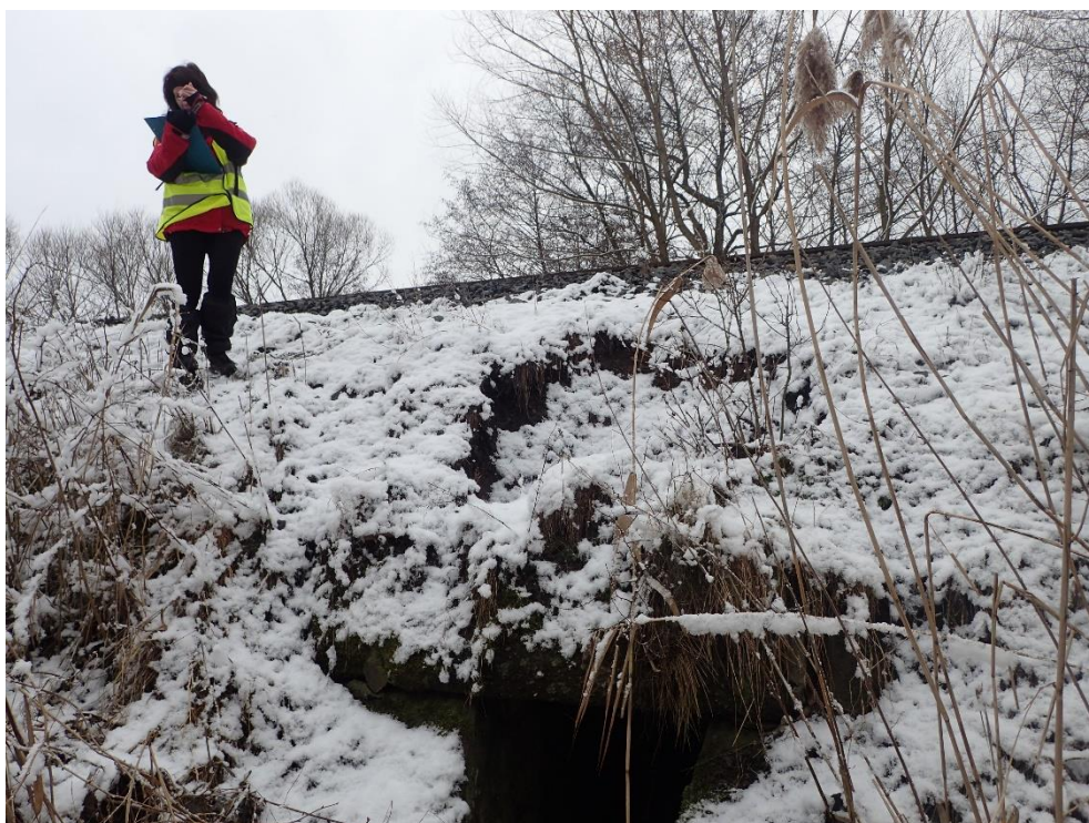
Foto 4: Svahová deformace nad římsou
