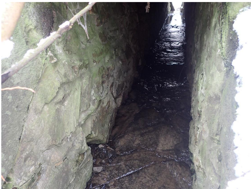
Foto 3: Místy uvolněné a vypadané kameny včetně spárování
